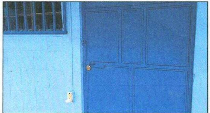
Foto 2: Mantenimiento a puertas (lijado, cepillado, sujeciones, aplicación de pintura), Sustitución de chapa
